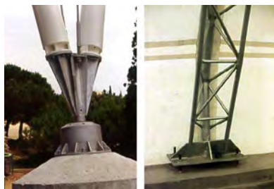
6.1.- Bases de mástiles. Transmiten compresión y suelen estar articuladas para evitar la flexión, a menos que se requiera que el mástil sea autoportante. Pueden incorporar mecanismos para el pretensado de la cubierta. Auditorio del "Camp de Mart", Tarragona. Polideportivo de Pozuelo de Alarcón
