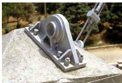
6.2.- Anclaje de tirantes. Son placas perforadas para recibir el terminal en horquilla del cable o el accesorio de fijación, que queda articulado para que se pueda colocar en la dirección del tirante sin que se produzcan excentricidades. Auditorio del "Camp de Mart", Tarragona. Obsérvense los refuerzos (corona, aletas y cartelas) que van transmitiendo progresivamente la carga del tirante al cemento.
